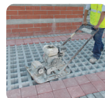
Vibrado de Adoquín
